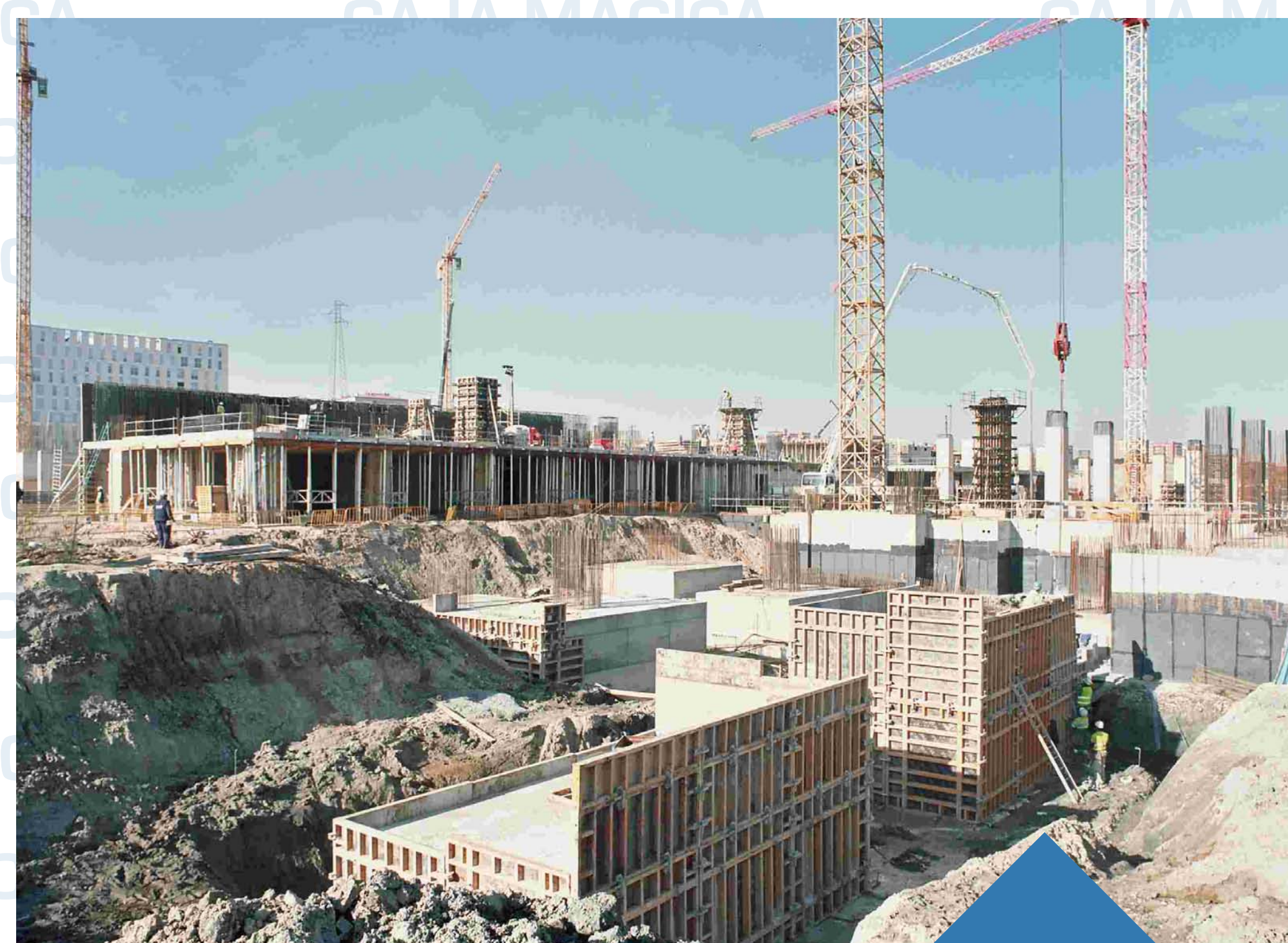
Encofrado de zapatas de cimentación para pilares en Estadios 2 y 3.
