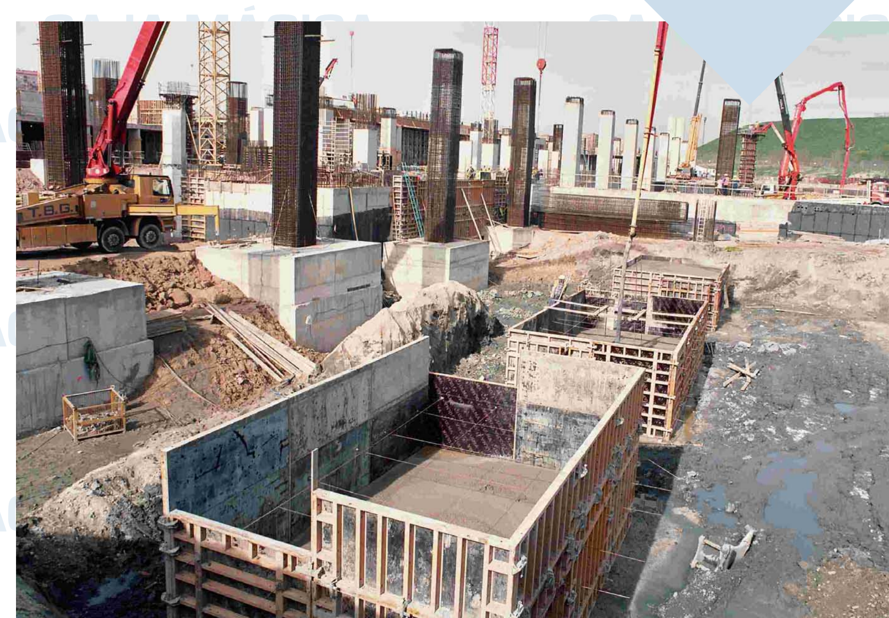
Encofrado de zapatas de cimentación para pilares en Estadios 2 y 3.
